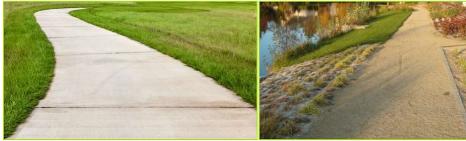
Figure 19 : Chemin en sable stabilisé et chemin en béton (Source : Espace Libre)
