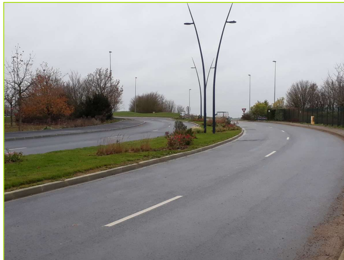
Figure 73 : Accès à la ZAC Nord (source : SAFEGE - 12/2020)
