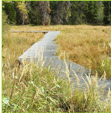
Figure 20 : Passage sur caillebotis galvanisé (Source : Espace Libre)
